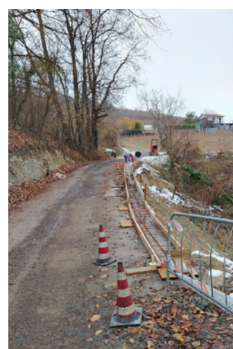
Ultimazione in corso dei lavori di messa in sicurezza di un tratto di strada consortile Richeria, interessata da una frana la scorsa primavera. Grazie anche al contributo economico dei consorziati.
