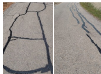
Sigillatura lesioni dell'asfalto di via Abelloni
