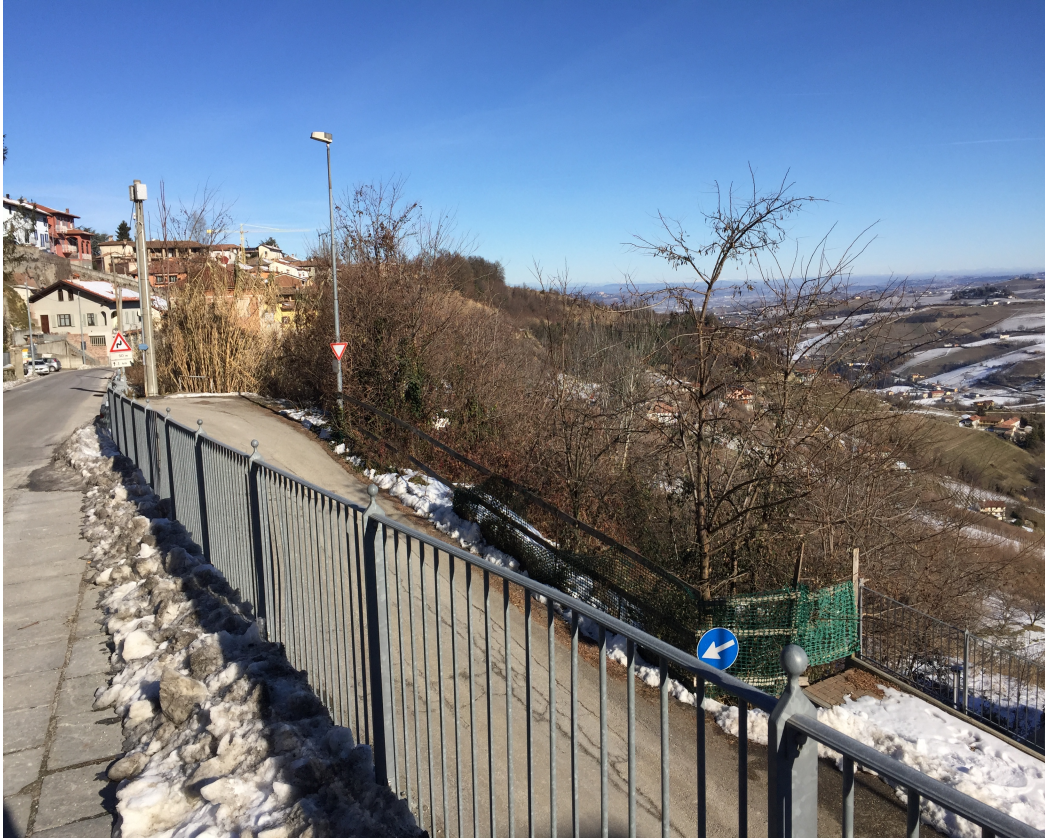
- Fotografia n. 1: Vista dalla strada provinciale;
