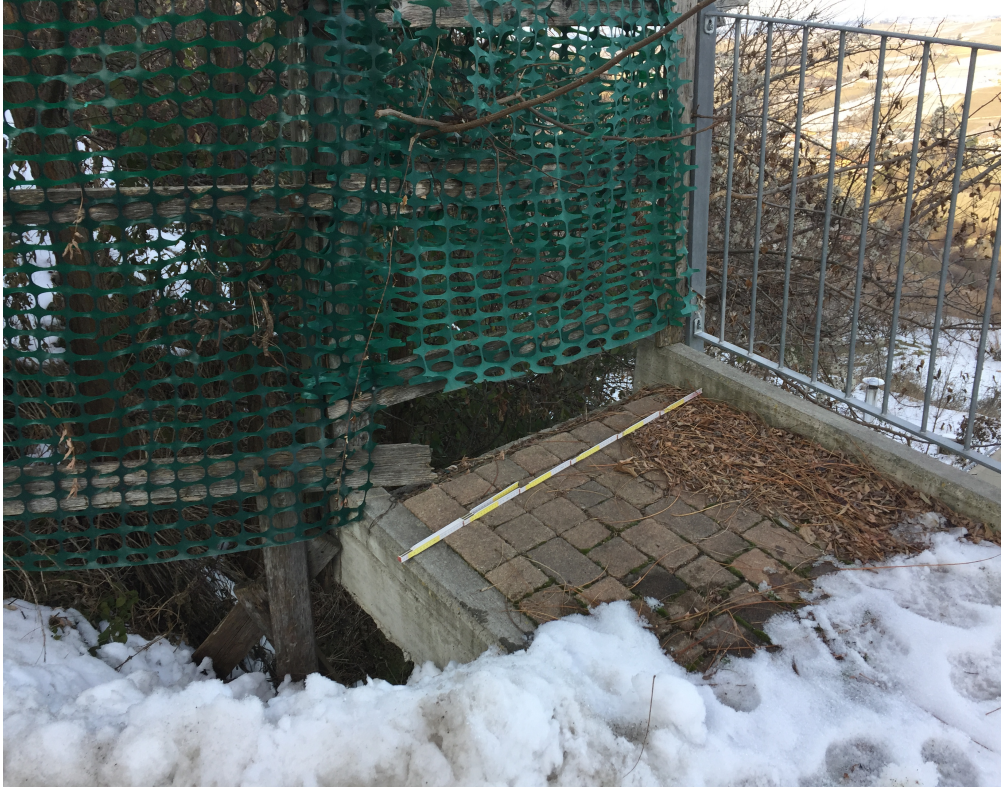
- Fotografia n. 3: Raccordo con marciapiede esistente;
