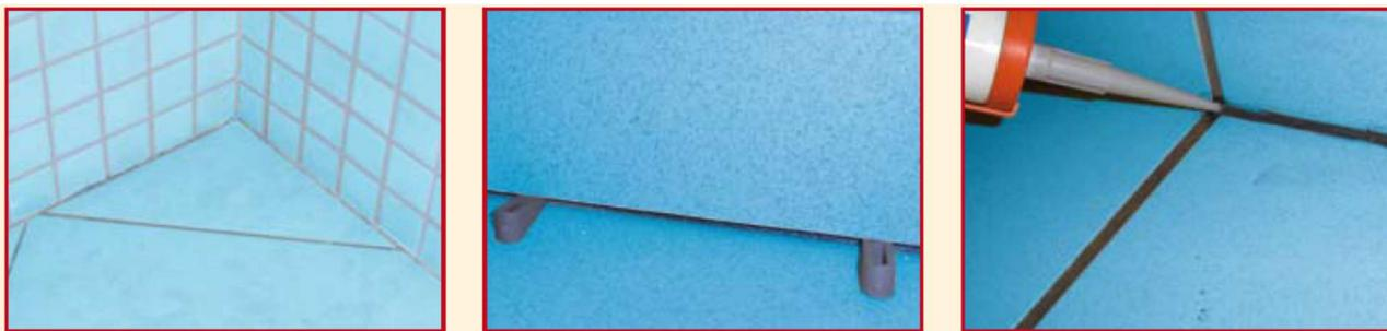
Per evitare che le vibrazioni prodotte dagli impianti idrici possano utilizzare come percorsi preferenziali quelli del pavimento e del battiscopa, si suggerisce di avere adeguata accortezza nel posare il rivestimento ceramico staccandolo dalla pavimentazione (battiscopa) in modo tale da sigillare la fuga con del materiale elastico ( es. silicone colorato).
